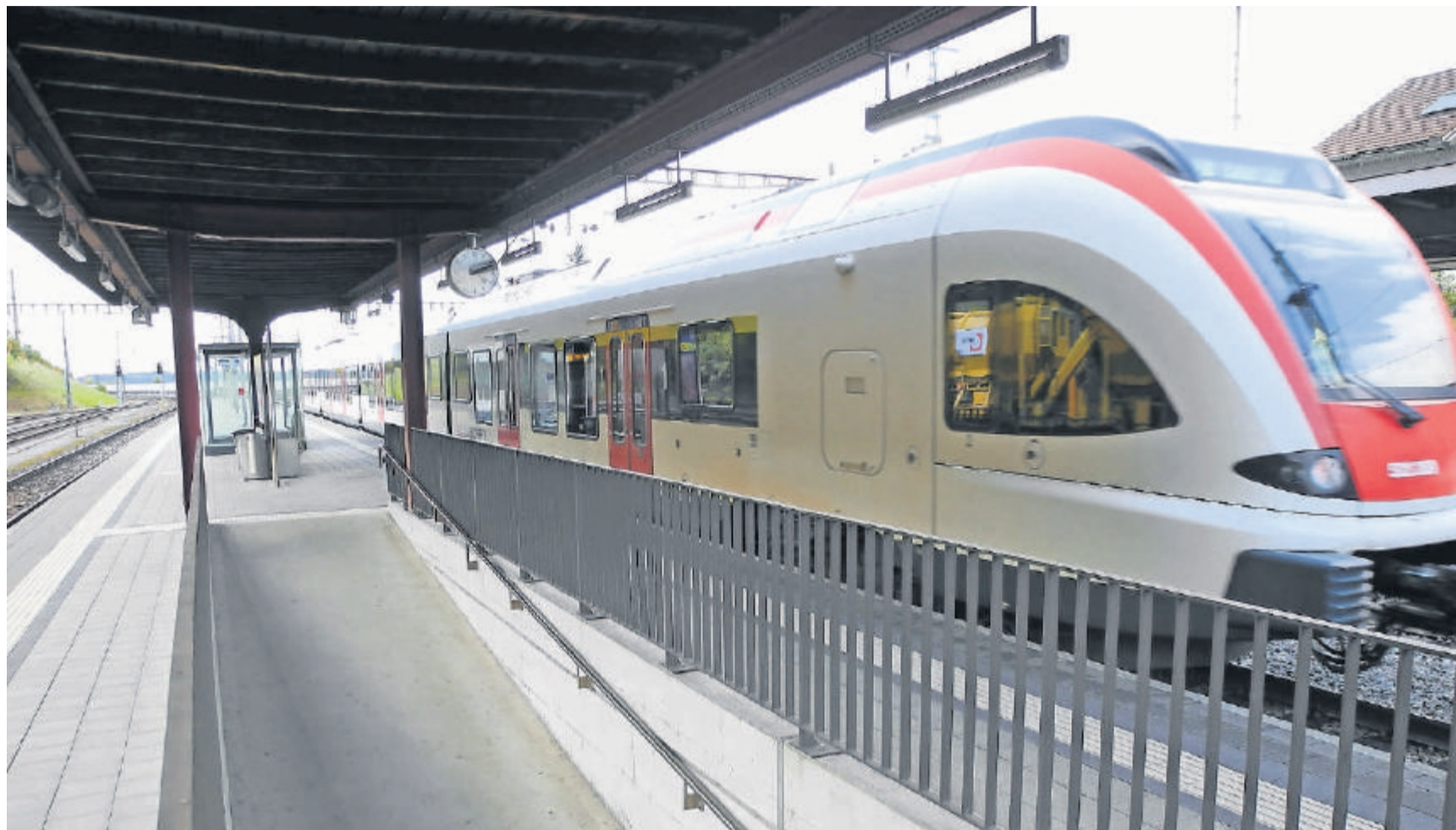
Rollstuhlfahrer, die mit der S1 in Stein ankommen, können ebenerdig aussteigen und die Rampe benützen.
